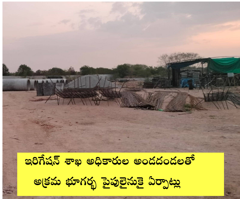
సొరంగ మార్గం ద్వారా అక్రమ భారీ సిమెంట్ పైపులను సమకూర్చుకోవడం
